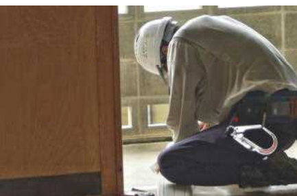
クーラーの設置作業
