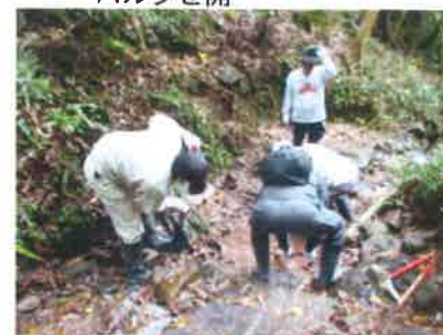
土砂を取り除く作業
