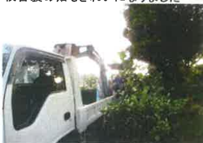
重機やトラックを使い整備
