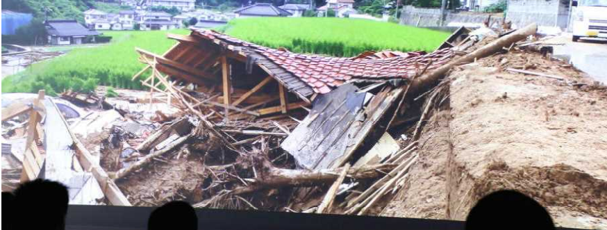
島県での土砂災害 (2014年8月20日)
